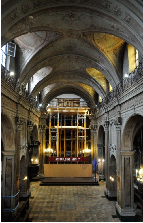
Navata centrale con puntellamento
