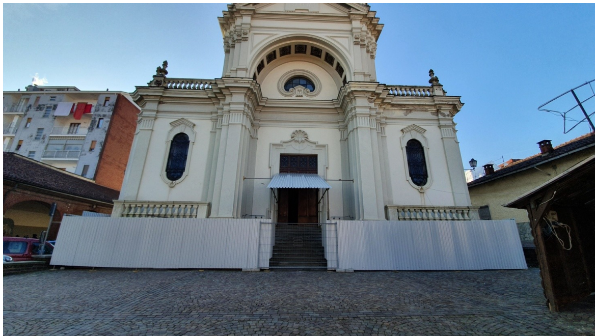
Facciata della chiesa con opere provvisorie per distacchi materiale 2021
