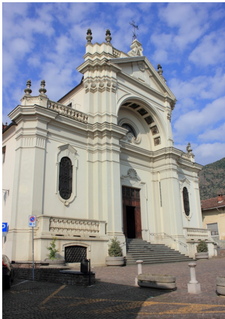
La facciata della chiesa nel 2016
