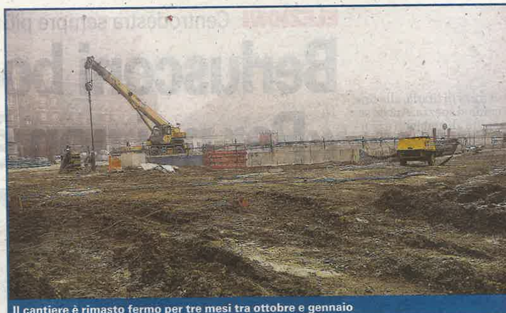
Il cantiere è rimasto fermo per tre mesi tra ottobre e gennaio
