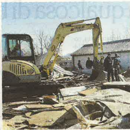
La demolizione delle baracche dei nomadi
