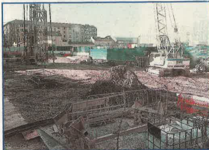
Il desolante aspetto del cantiere per la stazione Italia '61
