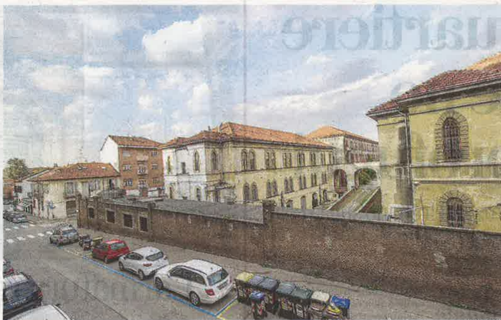
All'ex caserma Lamarmora in via Asti nelle scorse settimane ci sono stati diversi sopralluoghi
