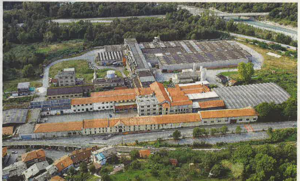
Una veduta degli stabilimenti, nati nel 1865, che fino al 2011 hanno dato lavoro a 130 dipendenti
