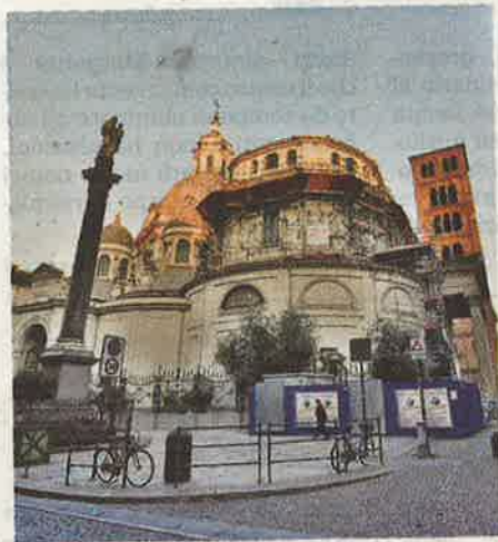
Il cantiere del santuario della Consolata
