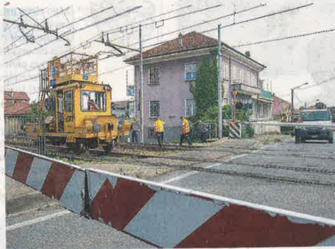
Operai al lavoro al passaggio a livello nel centro di San Maurizio
