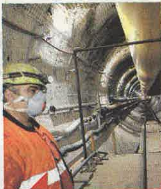
IL TUNNEL I lavori di scavo della galleria geognostica di Chiomonte
