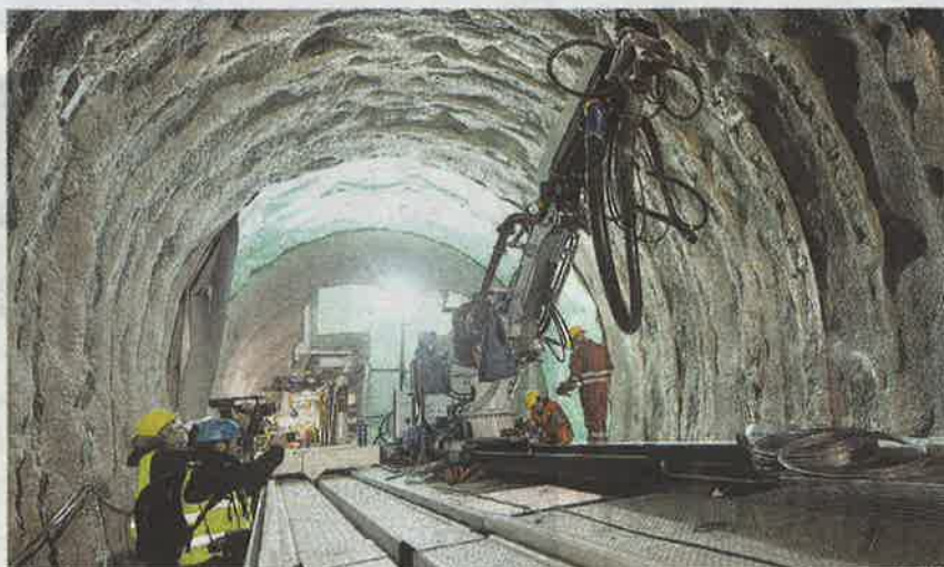
Il tunnel Avanzamento dei lavori di scavo del tunnel nel cantiere di Chiomonte per la realizzazione della linea ferroviaria ad Alta Velocità Torino-Lione
