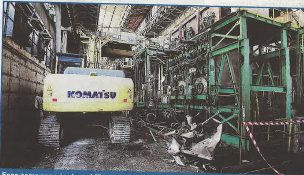
Ecco come appariva lo stabilimento a sette anni dalla tragedia
