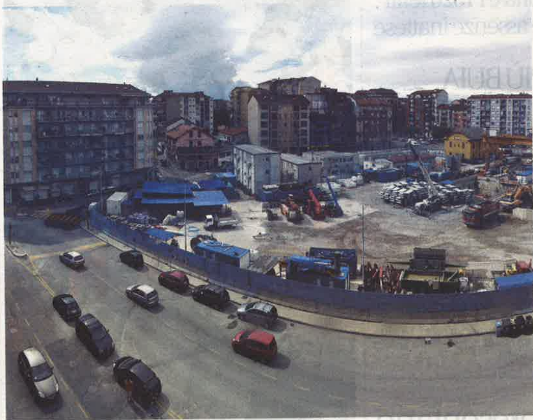
Il cantiere del metrò 1 in piazza Bengasi. A destra, gli operai festeggiano davanti alla talpa l'arrivo al Lingotto
