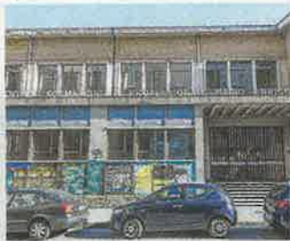
L'edificio di via Bardonecchia
