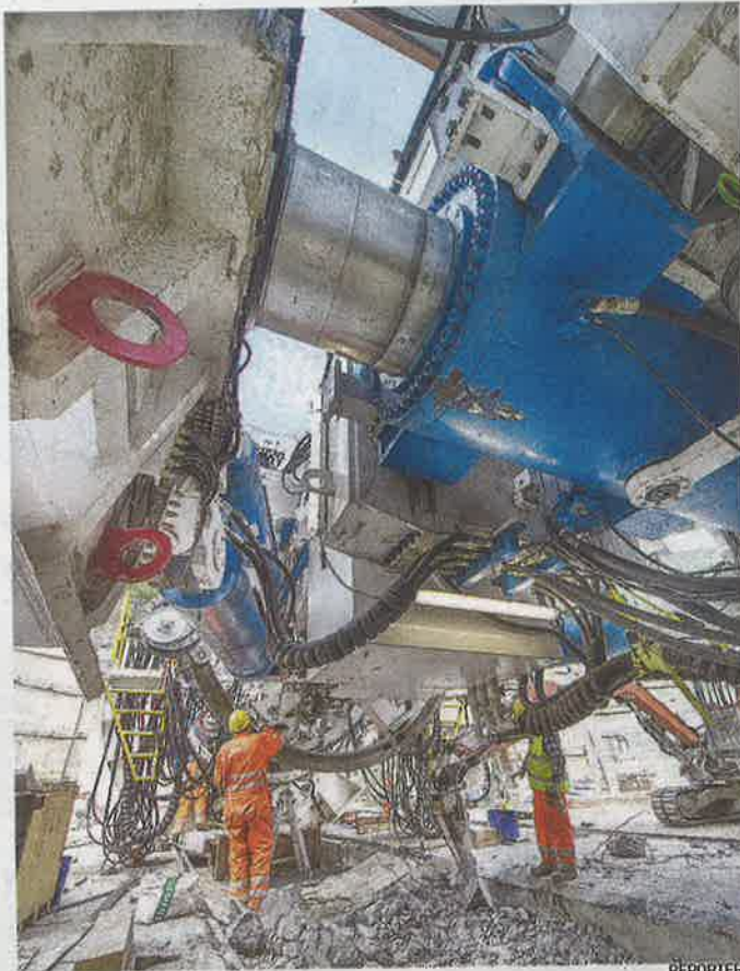
Il cantiere del tunnel geognostico della Tav, a Chiomonte
