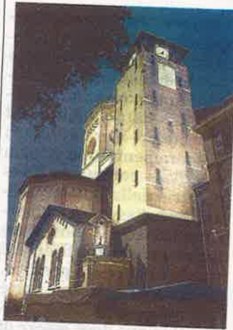
Il complesso illuminato
