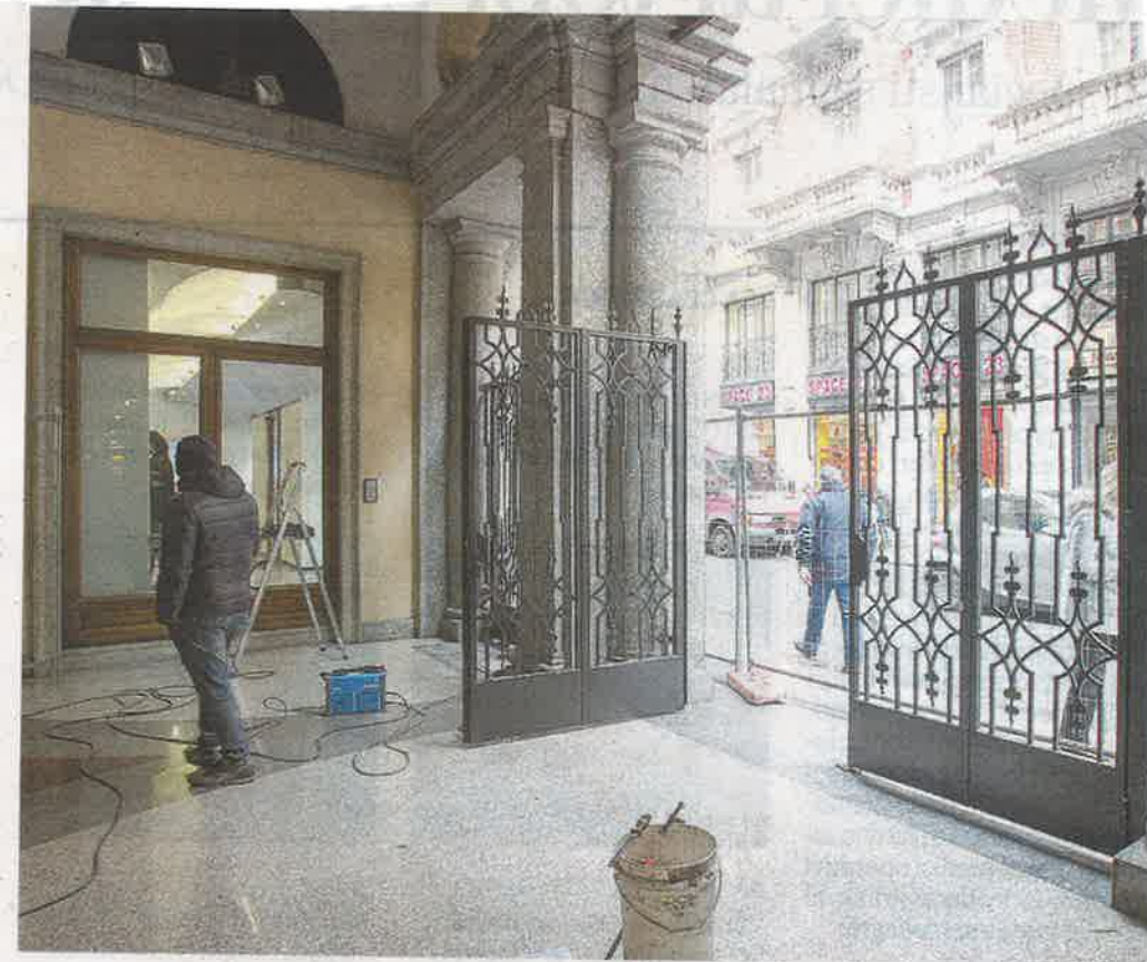
Le barriere installate ieri a protezione dell'ingresso
