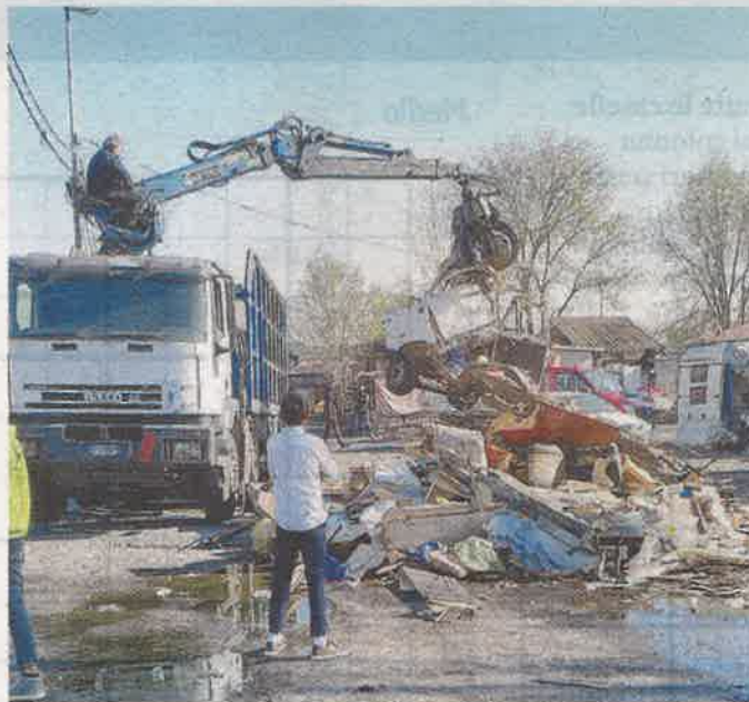
La rimozione delle baracche e delle roulotte abbandonate
