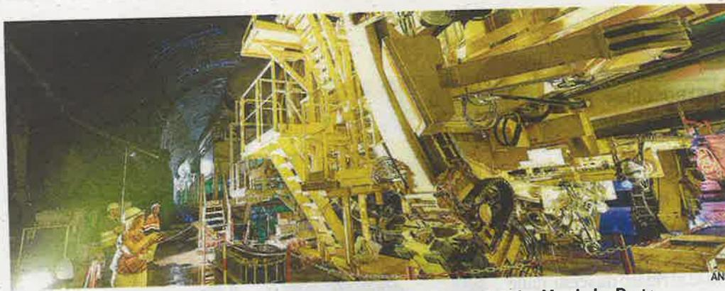
Il montaggio della fresa che sta scavando nel cantiere francese di Saint Martin La Porte
