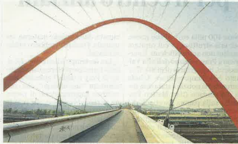
▲ Interrotta I cantieri riguardano un tratto della passerella olimpica
