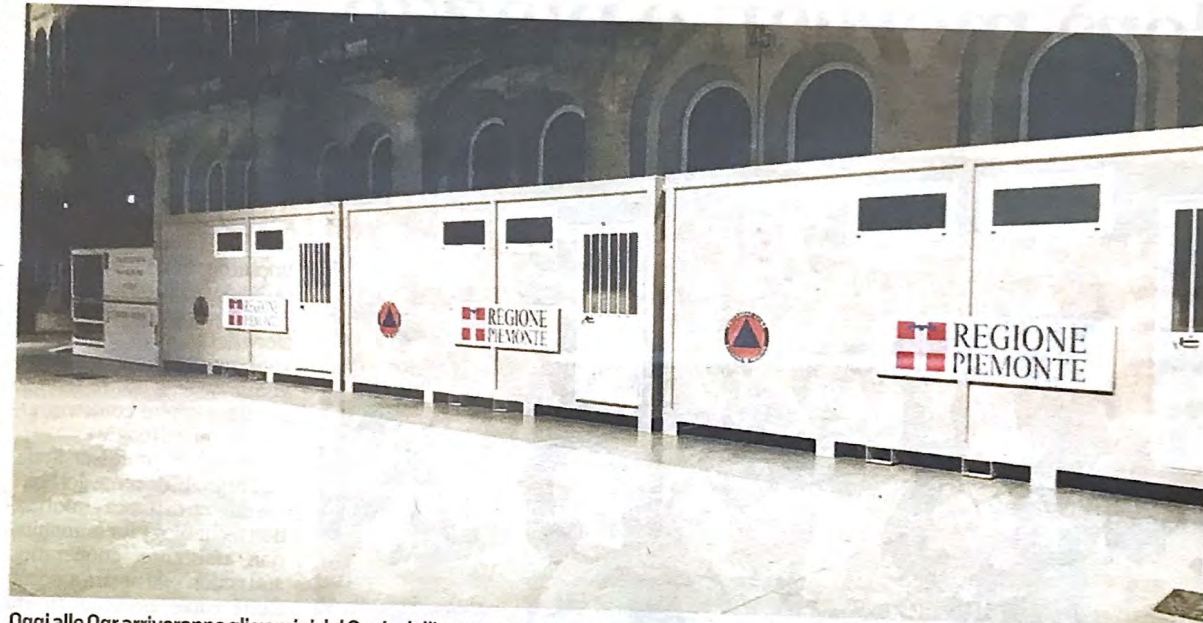
Oggi alle Ogr arriveranno gli uomini del Genio dell'aeronautica per avviare l'allestimento delle strutture sanitarie
