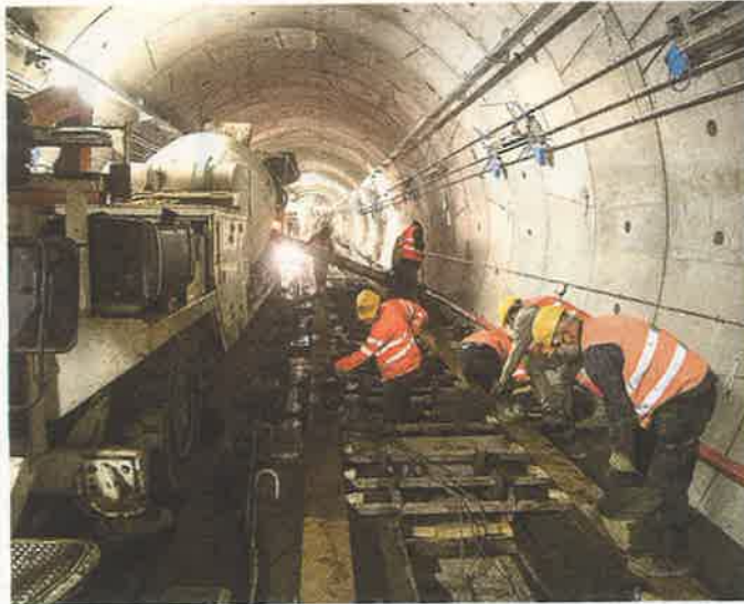
I lavori nel cantiere della metropolitana di Torino
