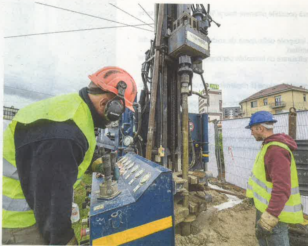
Sondaggio per la linea due della metropolitana in corso Orbassano
