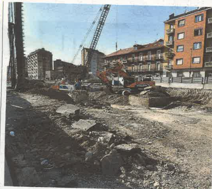
Il cantiere della nuova stazione: non sarà pronta prima del 2022
