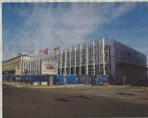
I cantieri in corso Bramante
