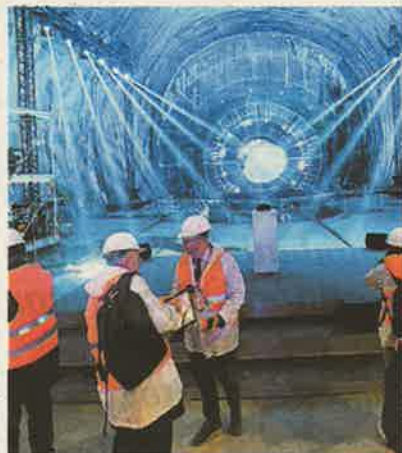
▲ Il maxi tunnel La costruzione della Torino-Lione prevede diverse opere compensative
