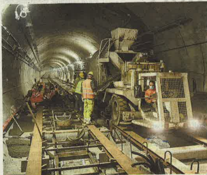
I lavori nel cantiere della metro sul tracciato esistente
