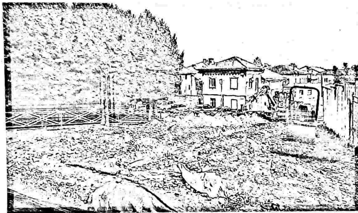
La scoperta causerà un ritardo nella chiusura del cantiere
