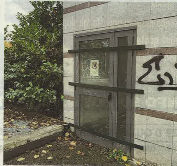
Uno dei varchi chiusi per evitare nuove intrusioni
