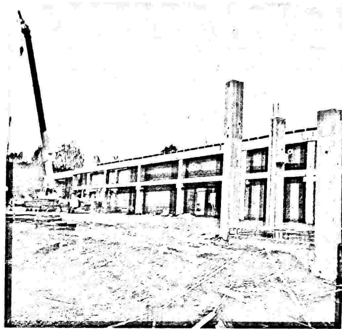
I lavori in corso Sebastopoli, tra via Tunisi e corso Unione Sovietica
