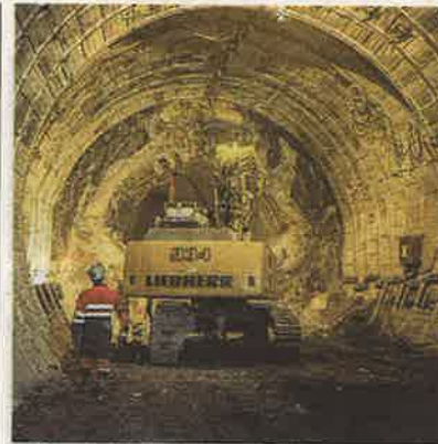
▲ Lo scavo Il lato francese del tunnel
