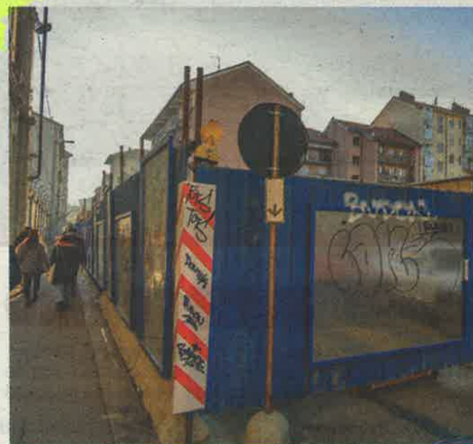
Il cantiere di via Vagnone per realizzare i 32 alloggi di social housing
